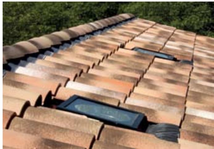
Le conduit de lumière respecte aussi bien l'harmonie extérieure qu'intérieure. Sur le toit, l'ouverture est intégrée à fleur de couverture et se confond parfaitement avec la toiture. À l'intérieur de la maison, la lumière est diffusée via un plafonnier blanc, élégant et discret.
